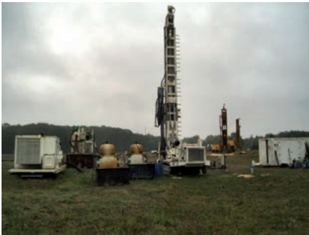
Figure 1. Creusement de puits sur un site du SNO H+ (réseau national de sites hydrogéologiques) pour l'élaboration de tests hydrauliques en interférences. © IC2MP, Gilles Porel
