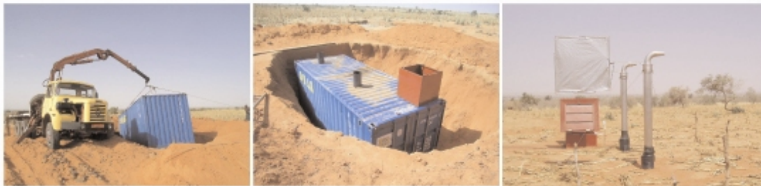
Laboratoire enterré pour la mesure et l'analyse in situ des particules Banizoumbou, Niger. ©AMMA-IRD-Jean Louis Rajot
