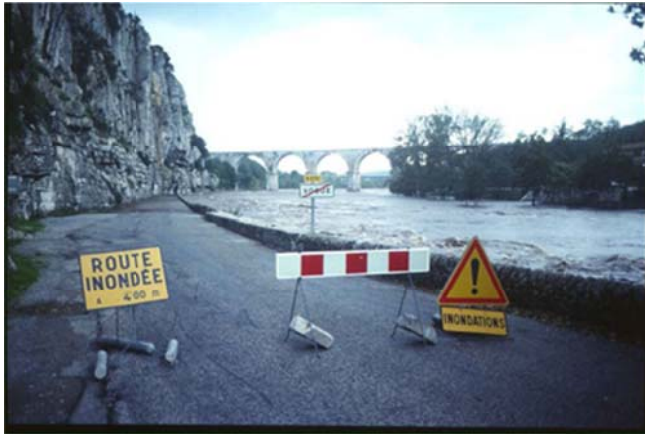
Crue de l'Ardèche – 20 octobre 2001 – route coupée à Vogüé © Michel Lang (IRSTEA).
