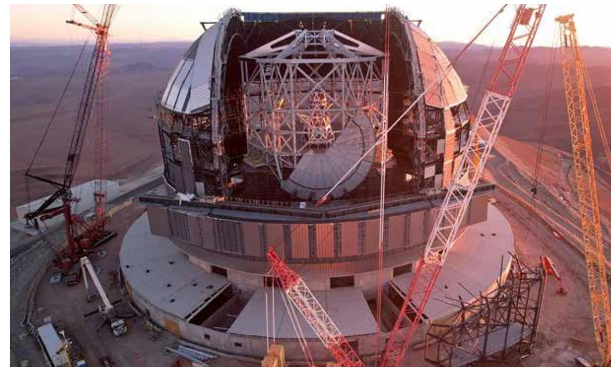
ELT en construction. © ESO
